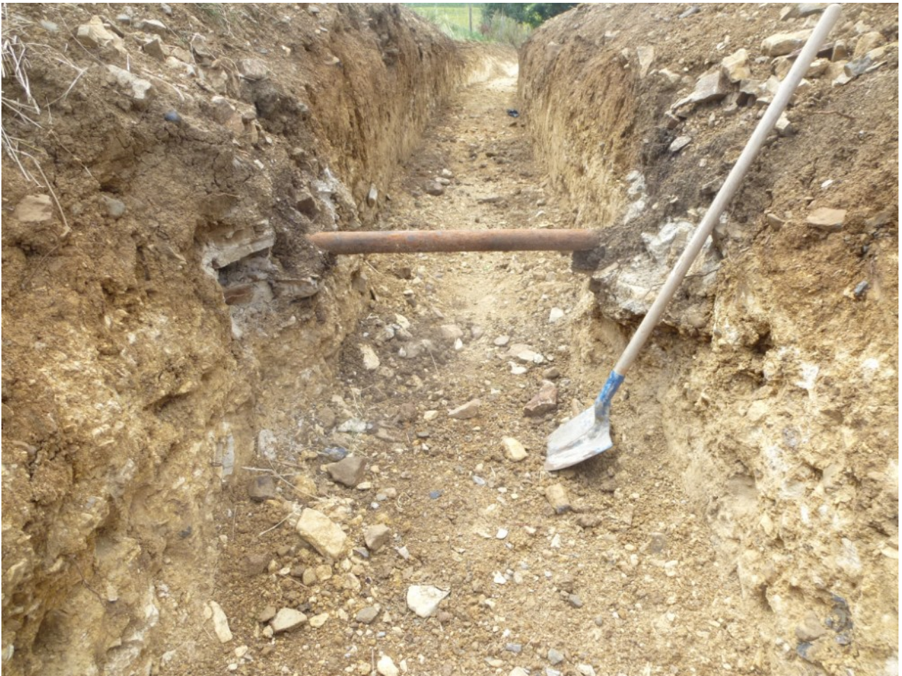
La tranchée Nord, selon une vue en direction de l'Ouest. L'ancien tuyau de fonte placé au fond du canal d'irrigation.
